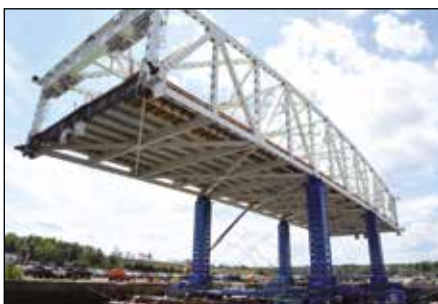
Elevación incremental de puentes
