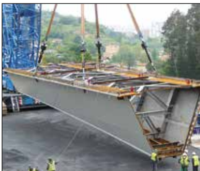
▼ Los segmentos del puente fueron levantados del suelo y posicionados a través de un sistema SyncHoist de 4 puntos con cilindros completamente monitorizados.
