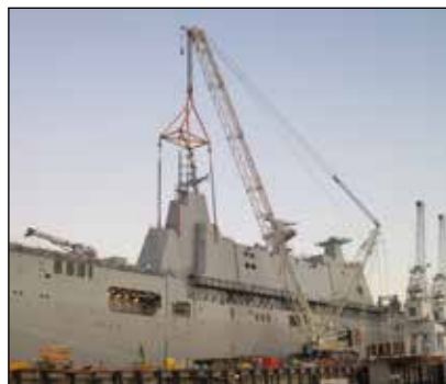
▼ Un sistema SyncHoist utilizado para alinear bloques de acero de las secciones de la torre de control del buque permite elevación y posicionamiento gradual de la carga.
